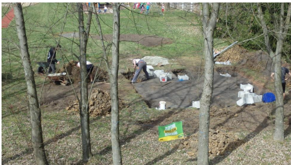
Betónovanie priestoru pod oporné piliere
