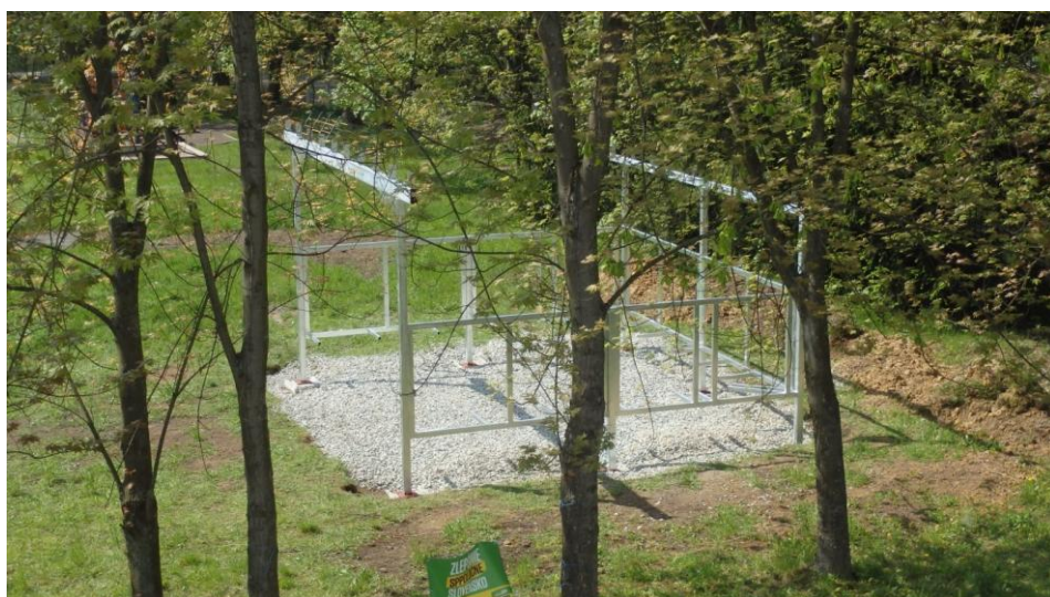
Nosná konštrukcia našej učebne v prírode je hotová
